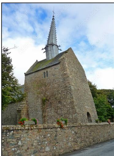
Le clocher incliné est à l'origine de la célébrité de cette chapelle. La flèche en plomb, posé en 1612 s'est rapidement inclinée, très lourde (couverte de plaques de plomb), sous l'effet des intempéries, sur une charpente mal adaptée et vieille de cinq siècles.
